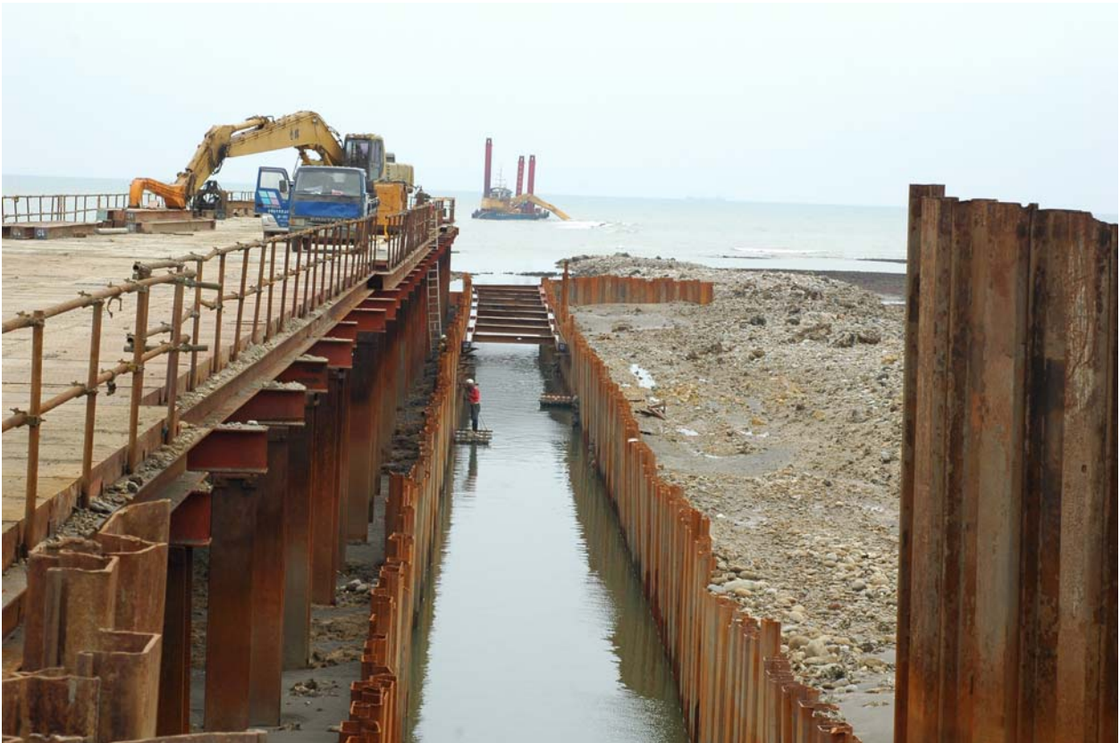
左側為 10m 之工作平台，中間 4m 完全開挖，挖開之土方直接覆蓋右側之藻礁上
