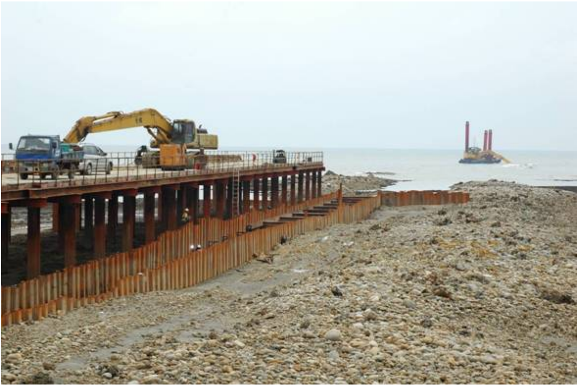
中油在桃園縣觀音海岸進行天然氣地下輸油管工程，直接在藻礁上開挖，挖出的土方又覆蓋在右側藻礁上
