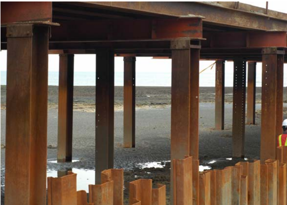
中油工作平台工程之鋼條樁腳直接插在藻礁上，礁體被嚴重破壞
